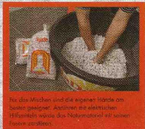
für das Mischen sind die eigenen Hände am besten geeignet. Anrühren mit elektrischen Hilfsmitteln würde das Naturmaterial mit seinen Fasern zerstören.
